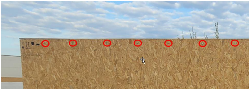
Abbildung 7: Schrauben der Deckelhölzer
