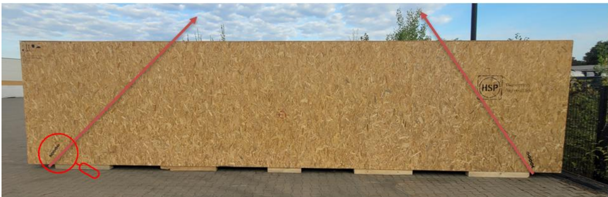
Abbildung 6: Anheben mit Kranschlingen
